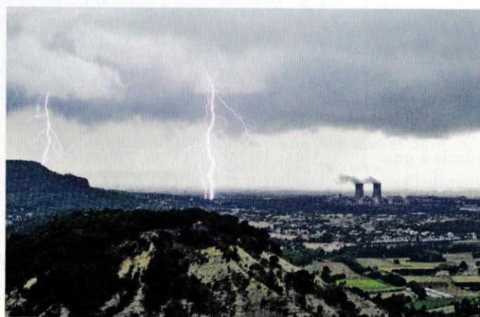
Doc2 . Les parties les plus visibles de la centrale sont les tours aérofrigorifères. Leur hauteur est de l'ordre de 150 m
